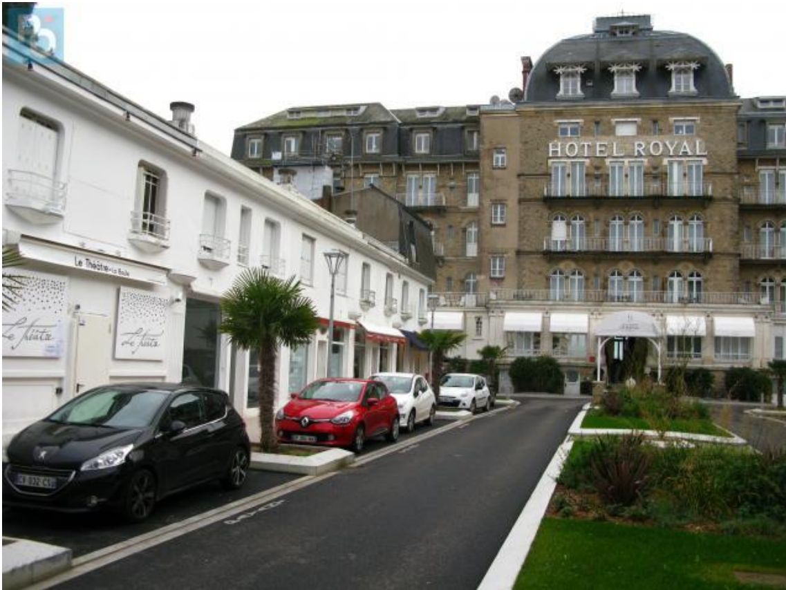
L'hôtel Royal avec le corps de bâtiment de l'ancien institut Verneuil et a été considérablement agrandi de deux ailes.
